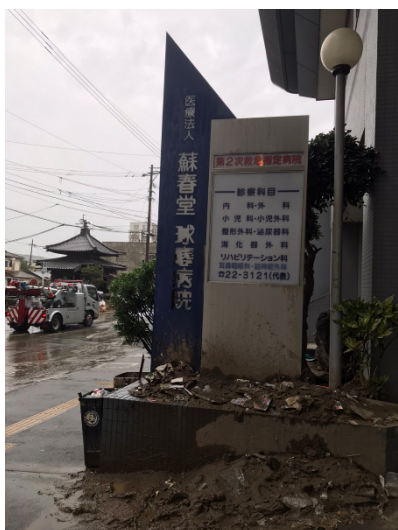
（被災した病院。人吉市上青井町に位置し、一階部分が浸水。）
